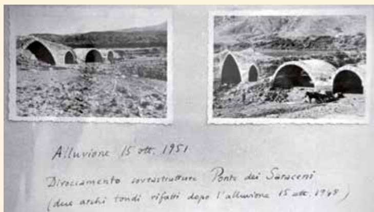
11. Il Ponte dei Saraceni: «Alluvione 15 ott. 1951. Diroccamento sovrastrutture Ponte dei saraceni (due archi tondi rifatti dopo l'alluvione 15 sett. 1948)» (Archivio Carcaci).
