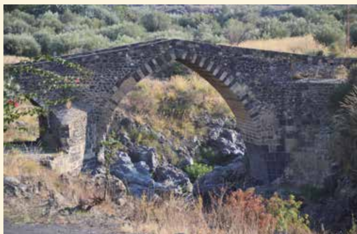
3. Vista a monte dell'arco maggiore. In primo piano un imponente frangiflutto posizionato tra i due archi medievali.
