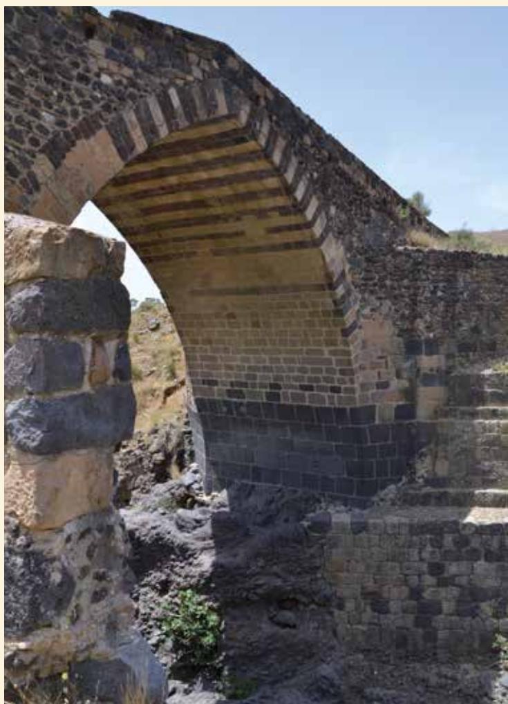
8. Ponte dei Saraceni. Arco acuto maggiore con evidente differenziazione cromatica del materiale.
